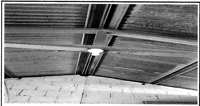
Foto 2: Reposición de focos ahorradores
