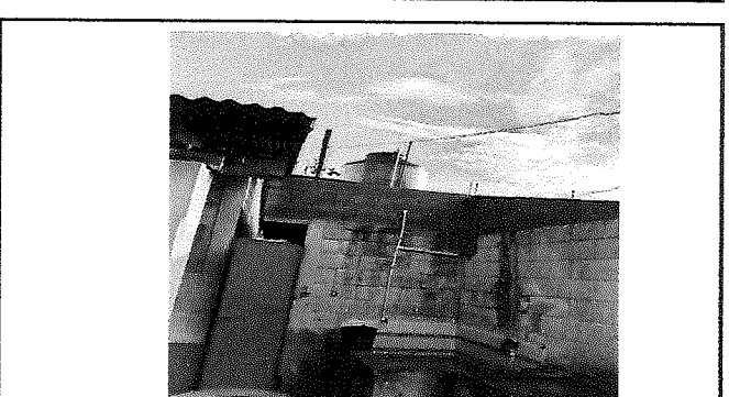
Foto 10: Sustitución de depósito de agua
