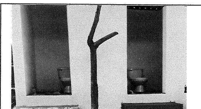
Foto 9: Sustitución de inodoros
